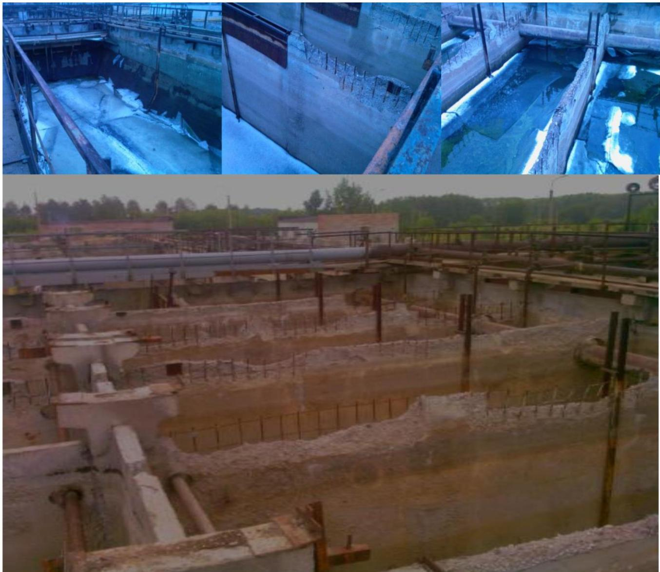
**Цель ремонтных работ: восстановление несущей способности, защита арматуры от внешних воздействий, восстановление проектных геометрических размеров и гидроизоляция конструкций.**
