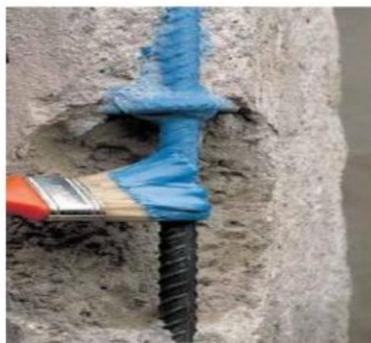
1. Защиту арматуры от коррозии следует проводить в том случае, когда существует вероятность образования на арматуре нового коррозионного слоя до укладки ремонтного состава (сильно агрессивная среда, температура точки росы ниже 5<sup>0</sup>С, большая влажность
